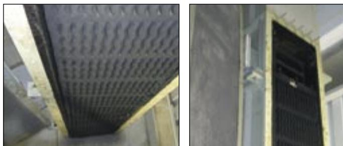
Exemple: Aérateurs ouverts à plaques profilées avec des dépôts oxydés de manganèse
